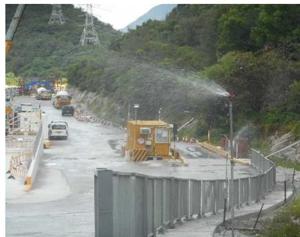
以自動灑水方式抑制塵埃產生
